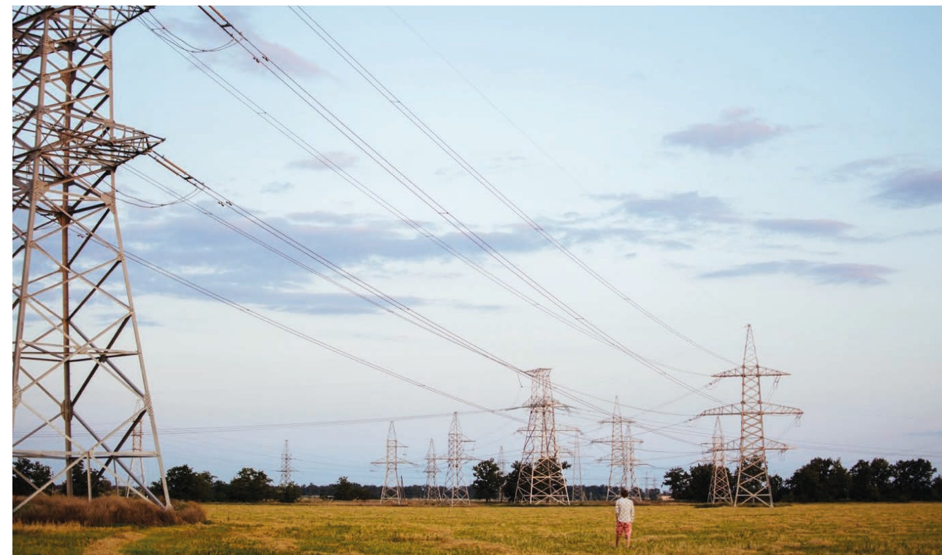
Ligne haute tension
