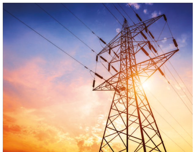
La flexibilité du système électrique est essentielle à la sécurisation des futurs approvisionnements en électricité, alors que les réseaux électriques supporteront l'essentiel de la transition énergétique.
